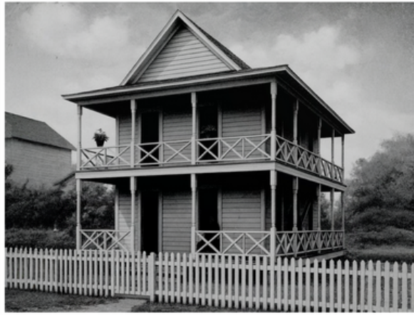
CASA EN BOCAS DEL TORO
